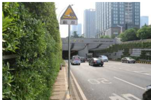
图 3 营养土和城市立面绿化工程
